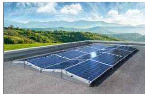
Ancoraggio moduli alla copertura mediante sistemi zavorrati speciali certificati, tipo SUN BALLAST 15° o equivalenti.
