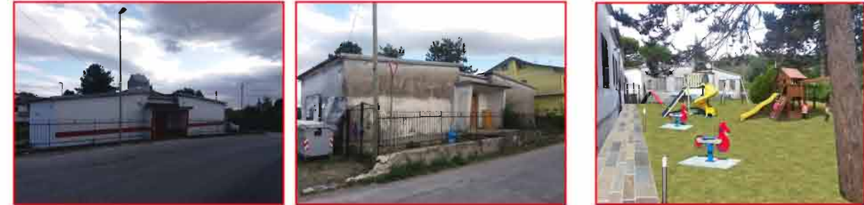
FRAZIONE COLLE CIOFFI – INTERVENTI PREVISTI: sostituzione delle coperture esistenti con tetti in legno lamellare, rifacimento e messa in sicurezza impianti idrico, termico ed elettrico, manutenzione straordinaria immobili e fornitura e posa in opera di arredi urbani.
